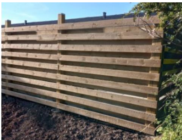
Vandret montering og mønster.
